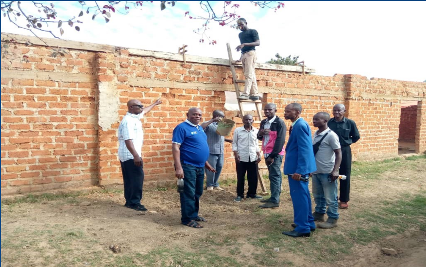
Le révérend Cimalanga (deuxième à gauche) et d'autres anciens de l'église inspectent les progrès de construction de l'église Matendo de la CEM en mai
